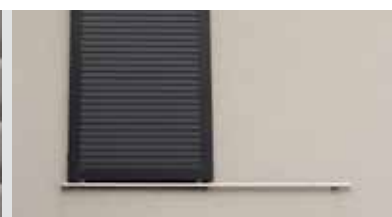
POSE SUR RAIL FILANT
