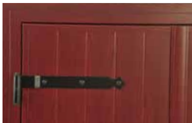
TABLIER AVEC AILE DE RECOUVREMENT
